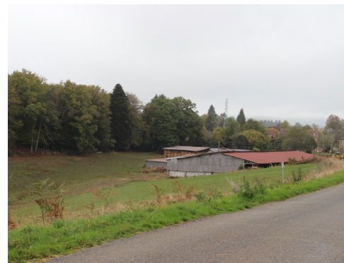
Bâtiment agricole vieillissant Virareix - Source : 6t 2018
