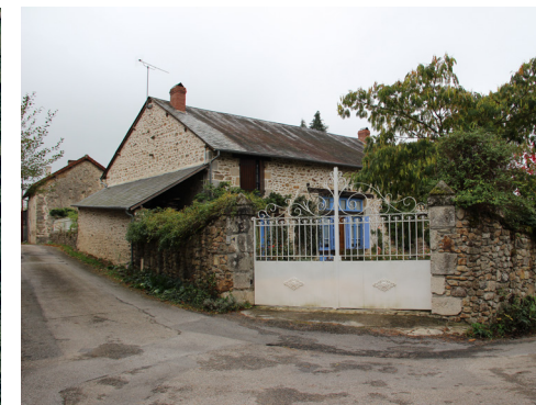
Forte présence de la pierre dans les constructions Bourg - Source : 6t 2018
